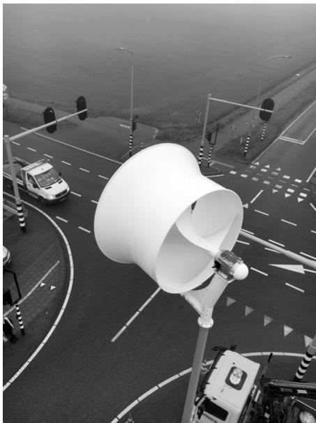
Een windturbine levert elektrische energie aan de verkeerslichten.
